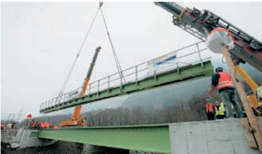
Einheben des 10 Tonnen schweren Dienststegs.
