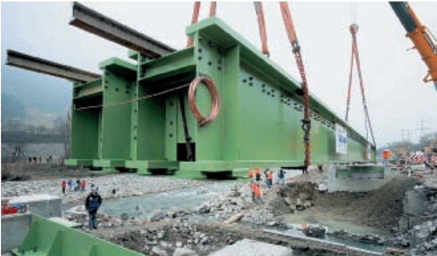
Einheben und exaktes Ausrichten der 90 Tonnen schweren Brücke.
