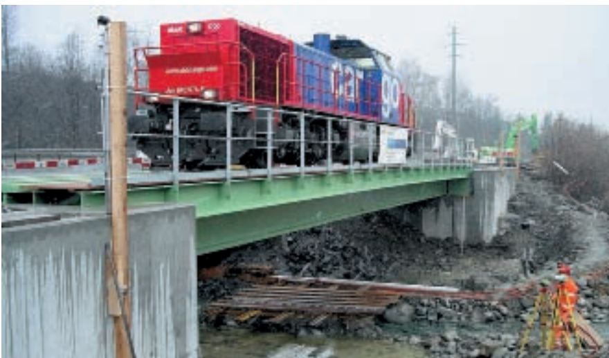
Belastungsprobe mit Deformationsmessung mit einer 80-Tonnen-Lok.
