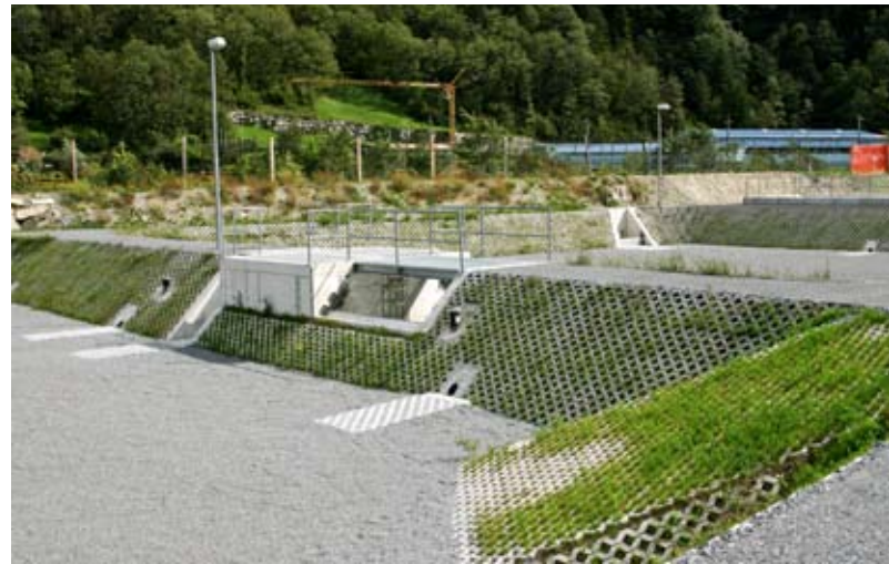
SABA für die A2 im Kanton Uri: Im Absetzbecken mit Lamellenfilter werden die Grobpartikel entfernt. Die Retentionsfilterbecken mit chemischen Adsorbentien nehmen gelöste Schadstoffe auf. (Bild: Basler&Hofmann)
