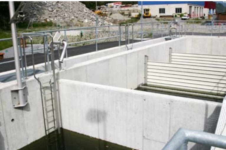
SABA für die A2 im Kanton Uri: Im Absetzbecken mit Lamellenfilter werden die Grobpartikel entfernt. Die Retentionsfilterbecken mit chemischen Adsorbentien nehmen gelöste Schadstoffe auf. (Bild: Basler&Hofmann)
