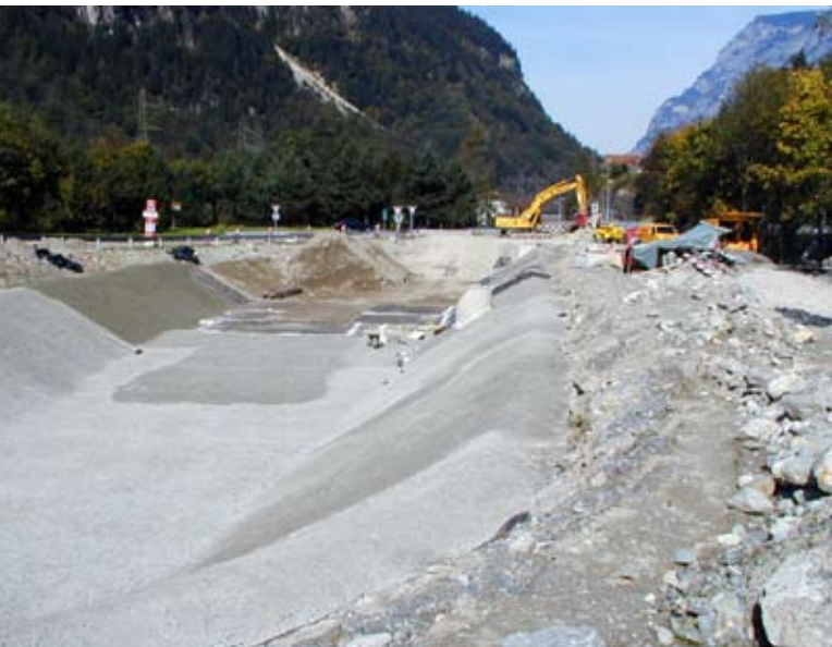
Bodenfilteranlage in Amsteg: Einbau der Abdichtung (links) und im Betrieb (rechts). (Bild: Basler&Hofmann)
