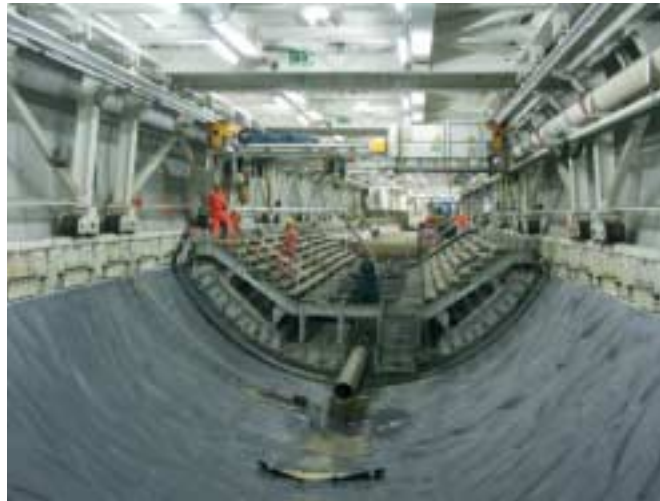
3 Herstellung Sohlbeton
