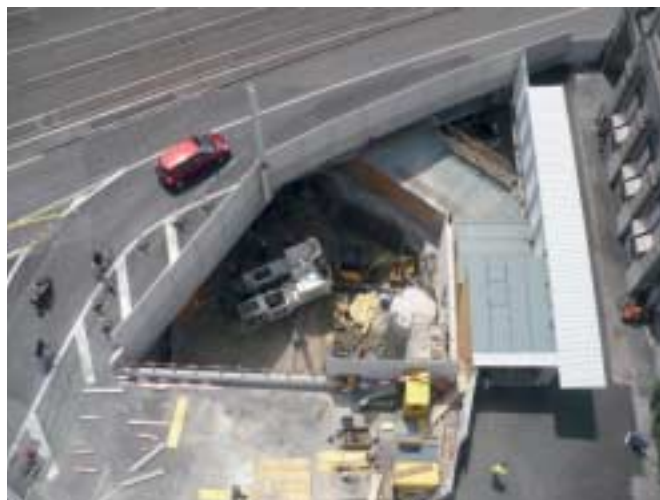
4 Hilfsbrücke über Schacht
