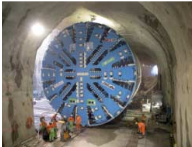
1 Querverschub der TBM
