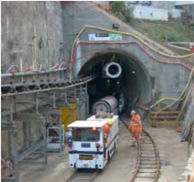
8 FLRS-Portal mit Ausbruchförderband
