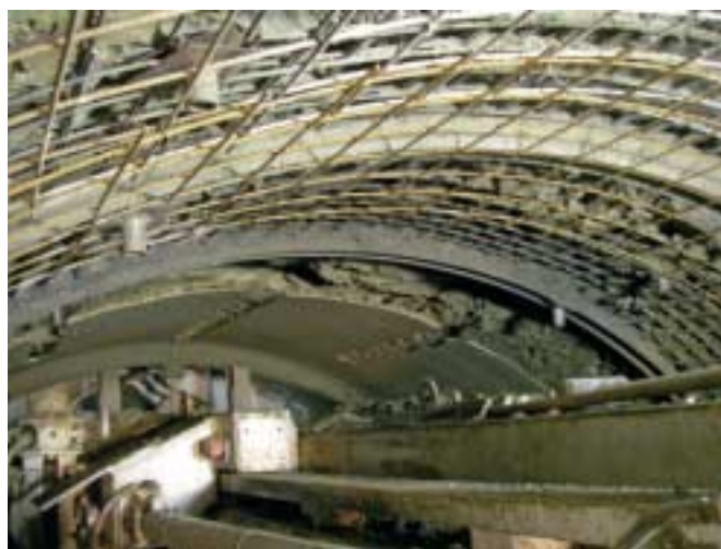
7 Längsstollen Süd: Ausbruch erste Rohrschirmetappe
