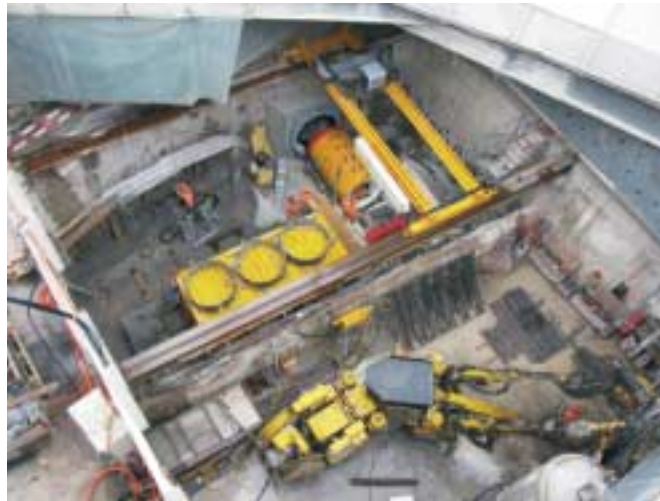
6 Zweigeteilter Schacht am Südtrakt
