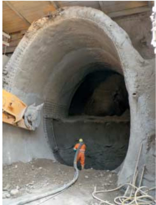
9 FLRS-Firstsicherung in der gebrächen Zone
