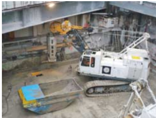
5 Schlitzwandbagger beim Aushub
