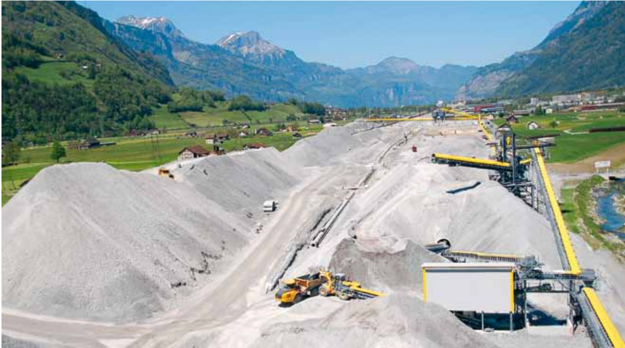
Wertvolles Baumaterial für Dammschüttungen: Zwischendeponie mit Gestein aus dem Tunnelvortrieb.
