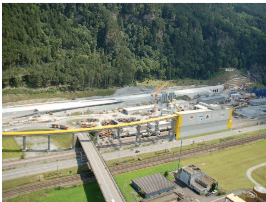
Abb. 1: Der Portalbereich bei Erstfeld: Die Bohrpfehlwand rechts sichert den Hangbereich unmittelbar vor dem bergmännischen Tunnelportal, links davon ist bereits der Tagbautunnel erstellt. Förderbänder und der Installationsplatz umgeben die Baustelle (Foto: AlpTransit Gotthard AG, Adrian Wildbolz).
