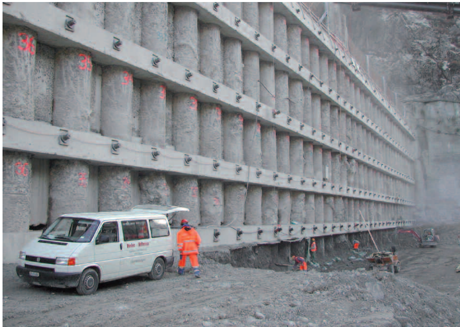
Abb. 2: Die rund 30 Meter hohe Bohrfahlwand (Foto: Basler & Hofmann).
