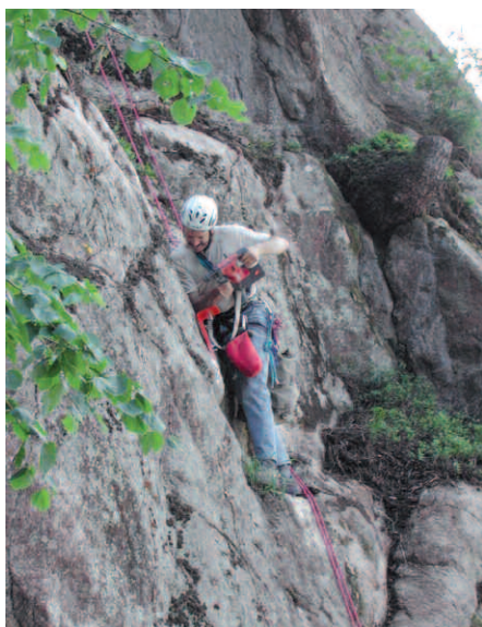
Abb. 3: Befestigen der Messpunkte oberhalb des bergmännischen Tunnelportals (Foto: Basler & Hofmann).
