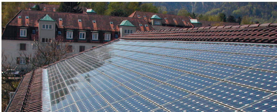
Oben: Aufdachanlage, die sich dank dunkler Solarmodule sehr gut in die Umgebung einfügt. Unten: optisch auffälligere Indachanlage.
