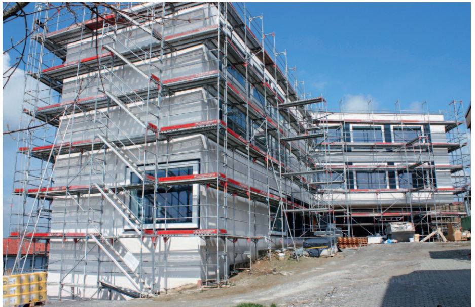
Der Bau von öffentlichen Gebäuden, insbesondere von Schulhäusern, verlangt eine professionelle Kommunikation mit der Bevölkerung.
