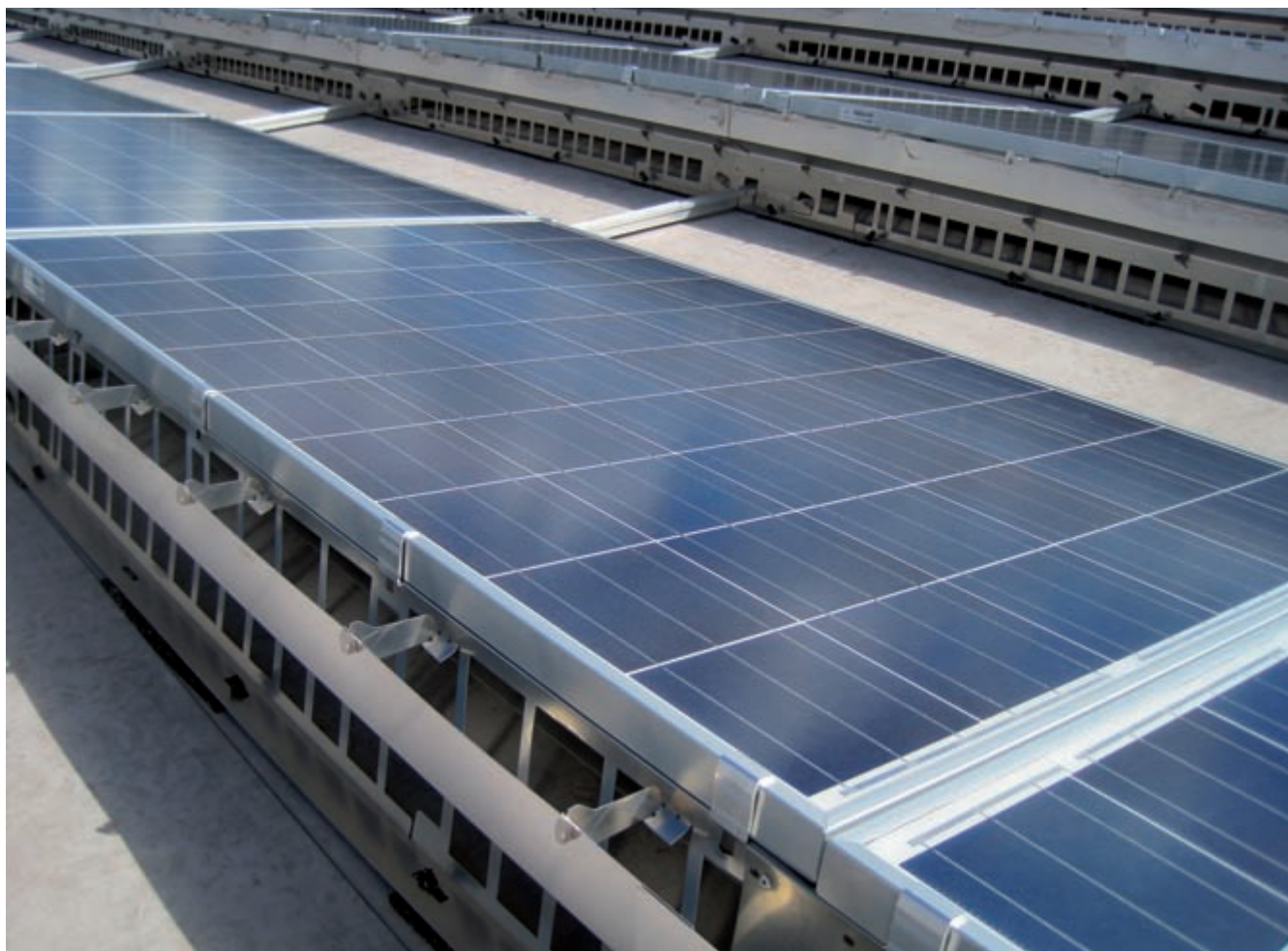
Bild 3 Leichtbauunterkonstruktion mit Spoiler am Heck des Aufständersystems.
