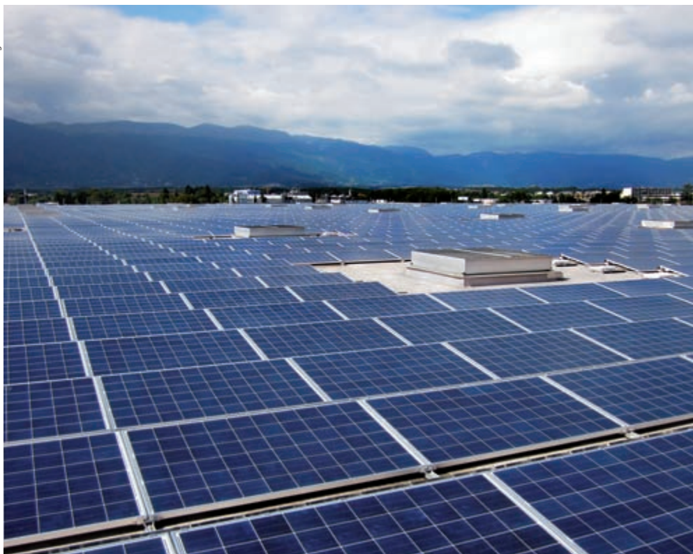
Bild 1 Blick auf Dachfläche in Genf.
