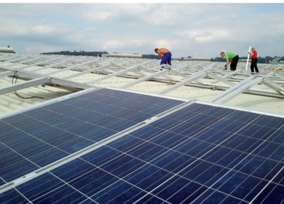
Bild 7 Modulmontage der 25 000 m 2 grossen Anlage auf der Industriehalle der Ferrowohlen AG.
