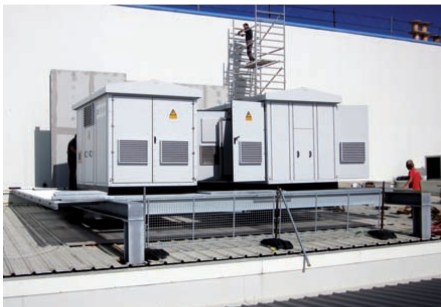
Bild 2 Container mit jeweils mehreren Wechselrichtern und einem Mittelspannungstransformator, aufgeständert auf dachdurchdringender Stahlkonstruktion.
