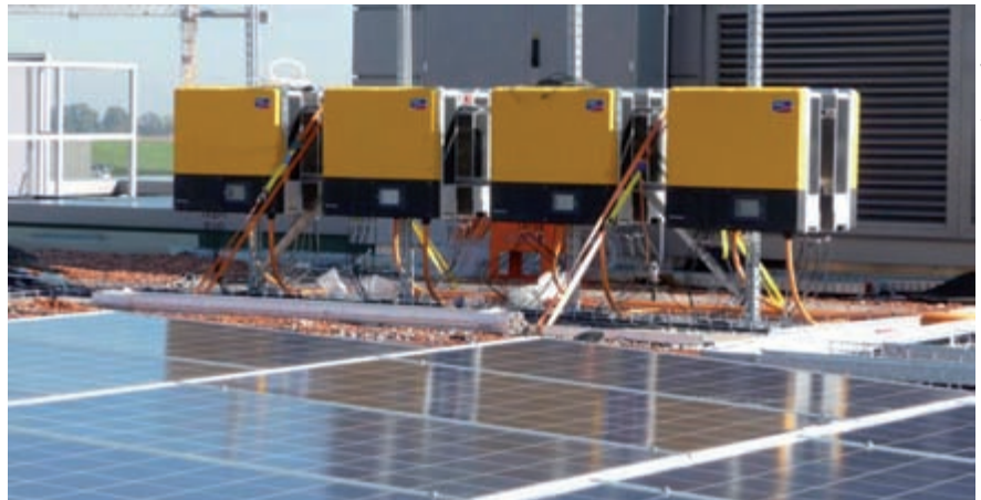
Bild 6 Die neueste Generation der Wechselrichter erreicht mit rund 98 % den höchsten Wirkungsgrad. Das Bild stammt aus der Bauphase der Solaranlage Pistor-Edisun Power.
