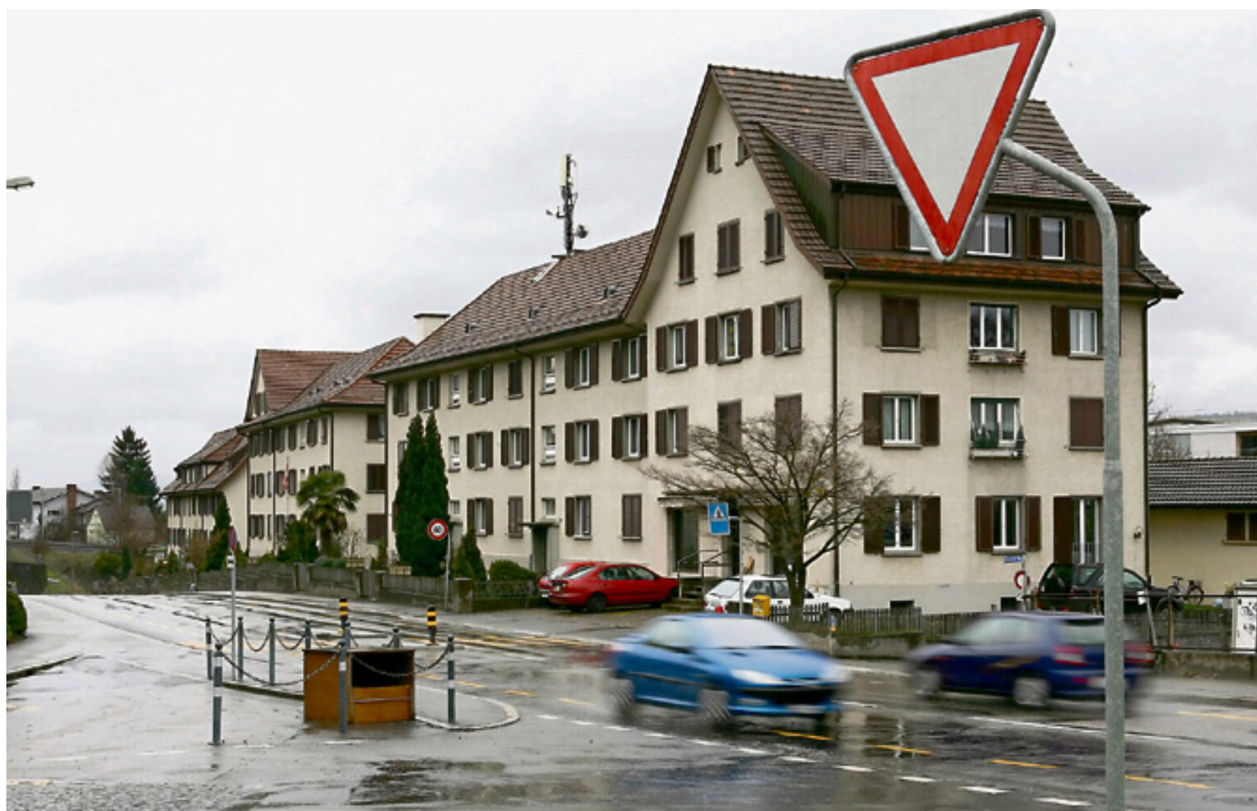
Die Siedlung Plattenhof wurde 1926 erbaut. Als Bauzeuge gilt sie nicht, das ergab ein Gutachten. Bild: Archiv André Springer
