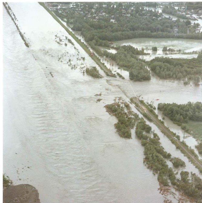
Abb. 3: Hochwasser 1987, Dammbrech bei Fussach (Quelle: IRR)
