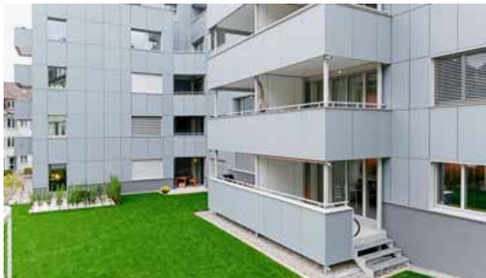
Blick von der Gartenseite: Das Gebäude wurde gänzlich neu eingekleidet.
