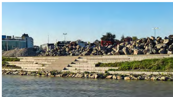
6 | Emmenstufen. 6 | Escaliers de l'Emme.
