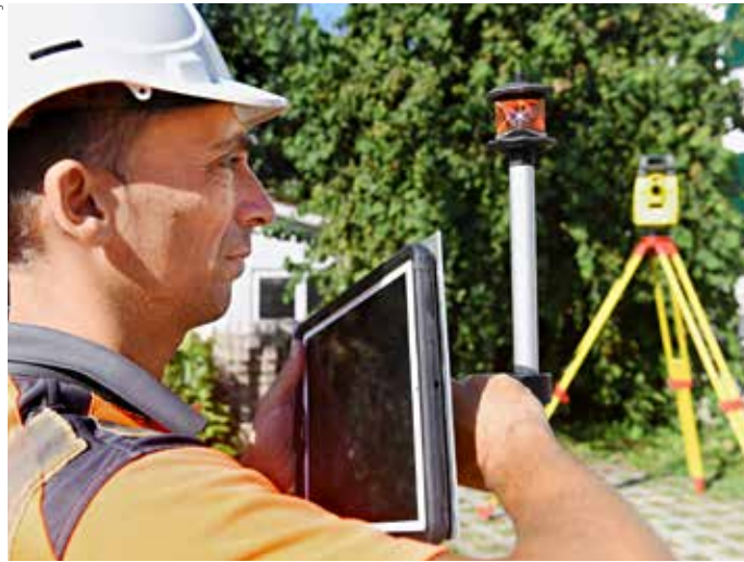
«Building Information Modeling» direkt auf der Baustelle: Der Polier steckt an der Eigenheimstrasse modellbasiert mit Tablet und Tachymeter ab.
