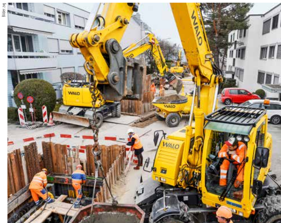
Bei der Sanierung der fünf Meter breiten Küssnacher Quartierstrasse herrschen enge Platzverhältnisse.
