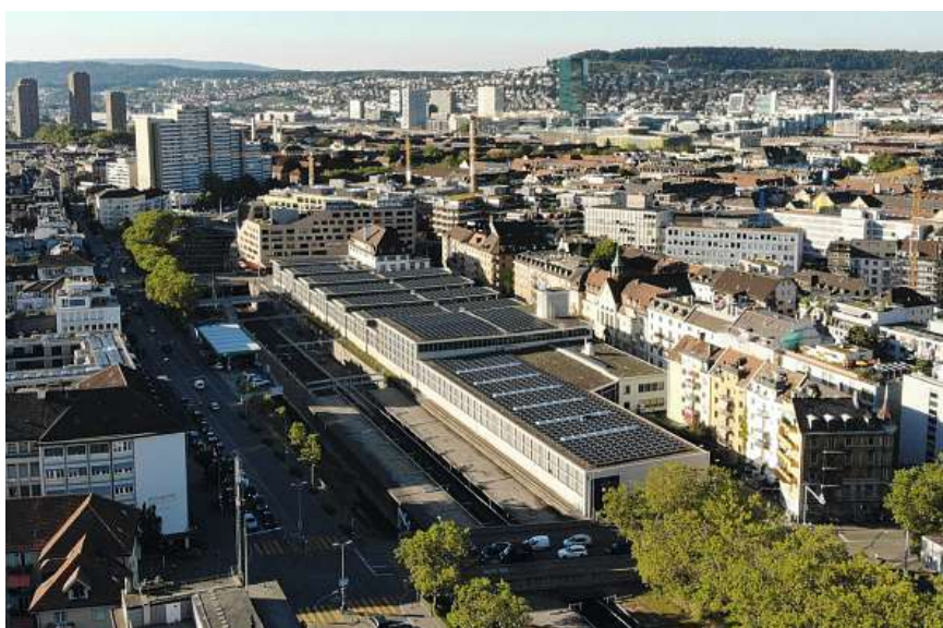
Im Rahmen einer 2019 fertiggestellten Gesamtanierung des denkmalgeschützten Tramdepots an der Elisabethenstrasse in Zürich wurde diese 470-kW-Photovoltaikanlage erstellt, die vorwiegend Traktionsstrom für die Trams erzeugt. Langfristig sollen alle Zürcher Tramdepots mit PV-Anlagen ausgerüstet werden.
