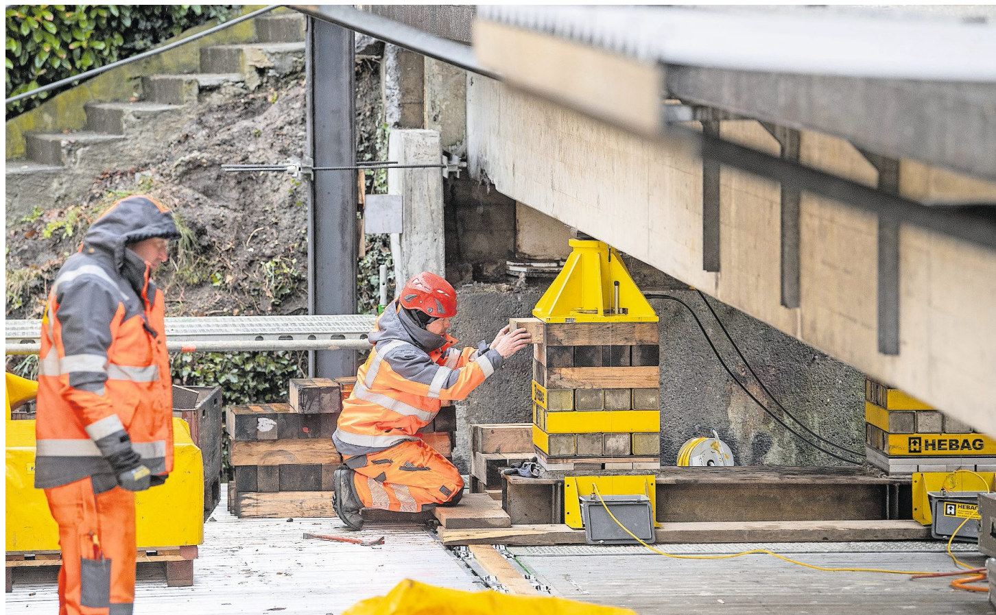
Die Brücke wurde mit hydraulischen Zylindern angehoben. Hier Spezialisten der Firma Hebag AG bei der Arbeit.
