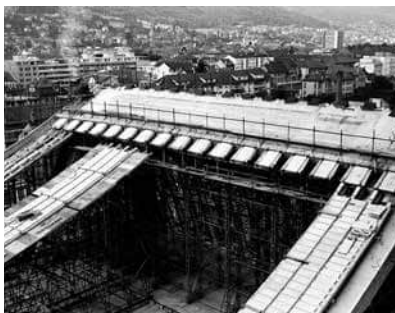
Erstellung des Hängedachs mit bereits verlegten Balkenkettens und vorfabrizierten Betonplatten dazwischen.
