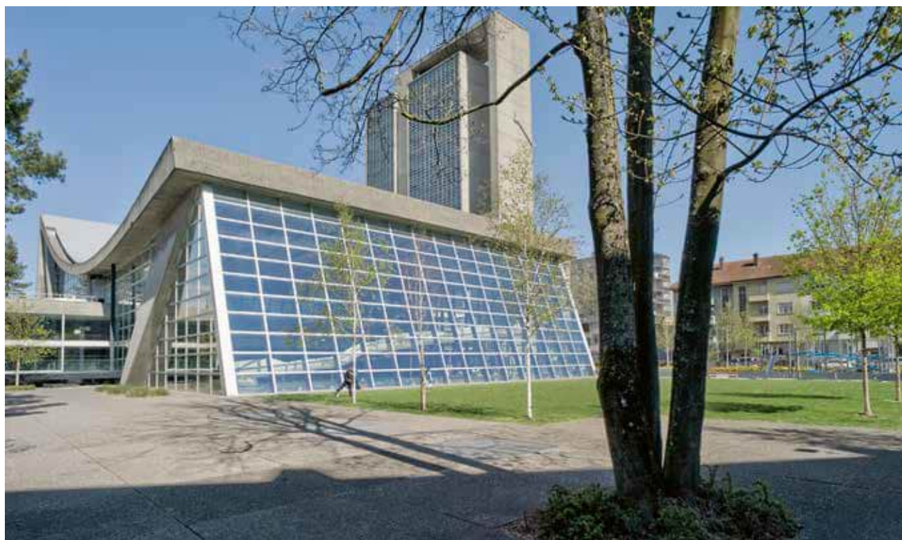
Hauptbau des Kongresshauses Biel (Südwestseite mit dem Hallenbad) und das Hochhaus im Hintergrund.
